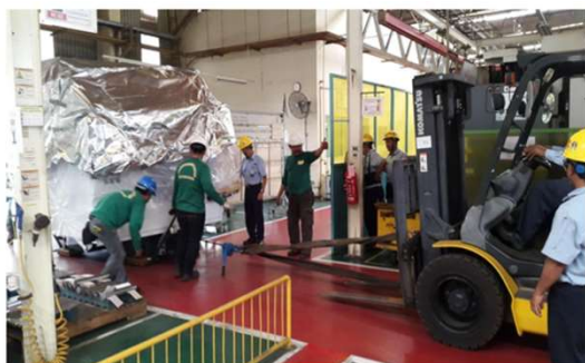
Relokasi dan Instal Machine
