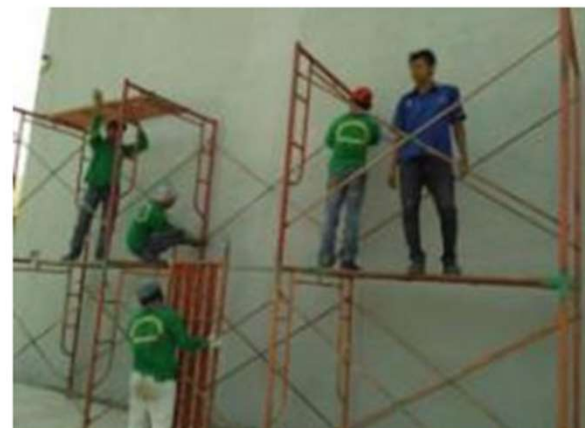
Perbaikan Dinding Retak dan Pengecatan Baru
